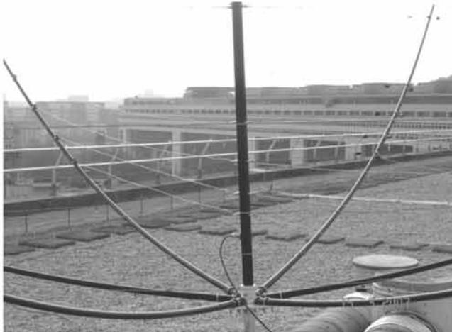
La veille, j'avais installé un tube de chauffage central, me faisant un solide mat de 7 mètres, ainsi que le rotor. J'ai acheté chez Holger un mat en aluminium de 1m de hauteur, et de deux millimètres d'épaisseur. Très solide et très léger il est installé entre l'antenne et le rotor.
